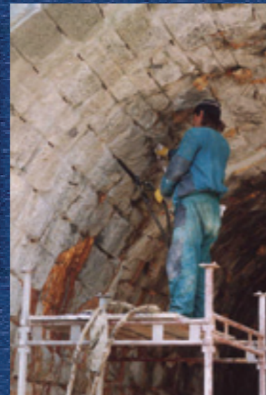
Injektiranje kamenog mosta, sanacija izolacije mosta i ojačavanje
