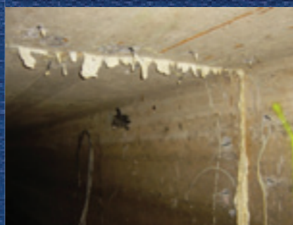
Zaptivanje spojnice i ojačavanje temelja zatvaračnice betonskog odvodnog kanala ispod nasipa za zaštitu od poplava na Dunavu u blizini Bačkog Novog Sela, Srbija
