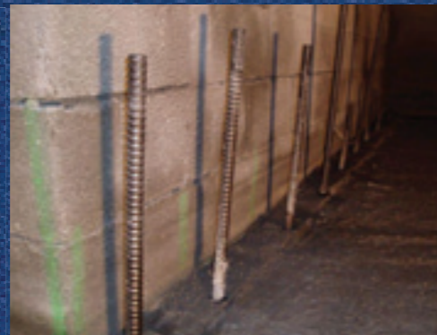
Ugrađivanje mikro-šipova u konstrukciju
