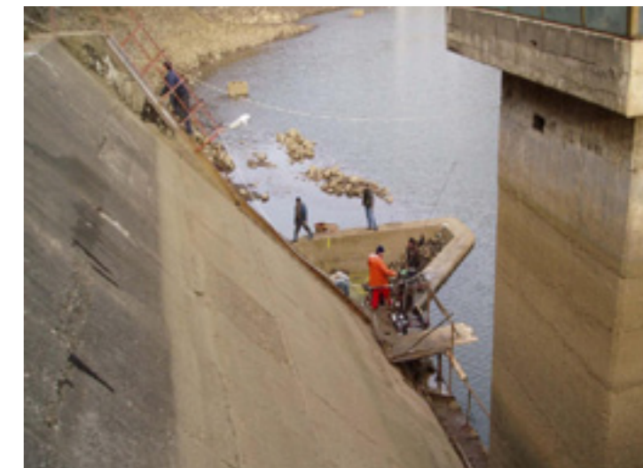
Zaptivanje tela brane Berdu u Rumuniji
