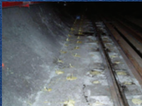
Ojačanje i zaptivanje betonskog tunela metroa u Budimpešti
