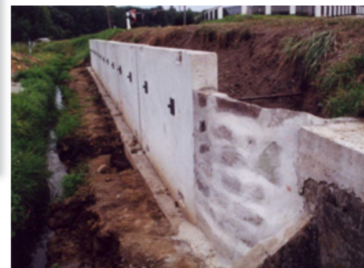
Sanacija potpornog zida ankerovanjem
