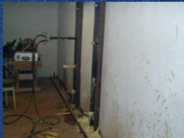
Osiguravanje stabilnosti prilikom rekonstrukcije zgrade
