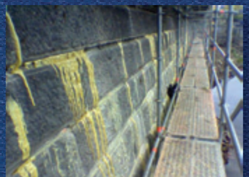
Zaptivanje i ojačavanje obaloutvrde Alsovo u Pragu posle poplava iz 2003
