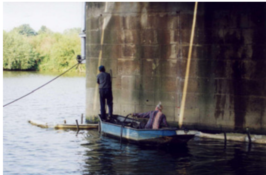
Ojačavanje nosivog tla i stuba mosta, ispod nivoa vode
